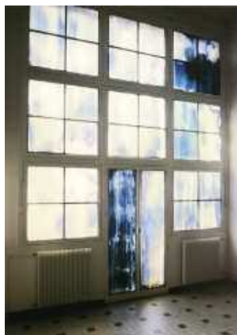
unmittelbar nach der Montage
